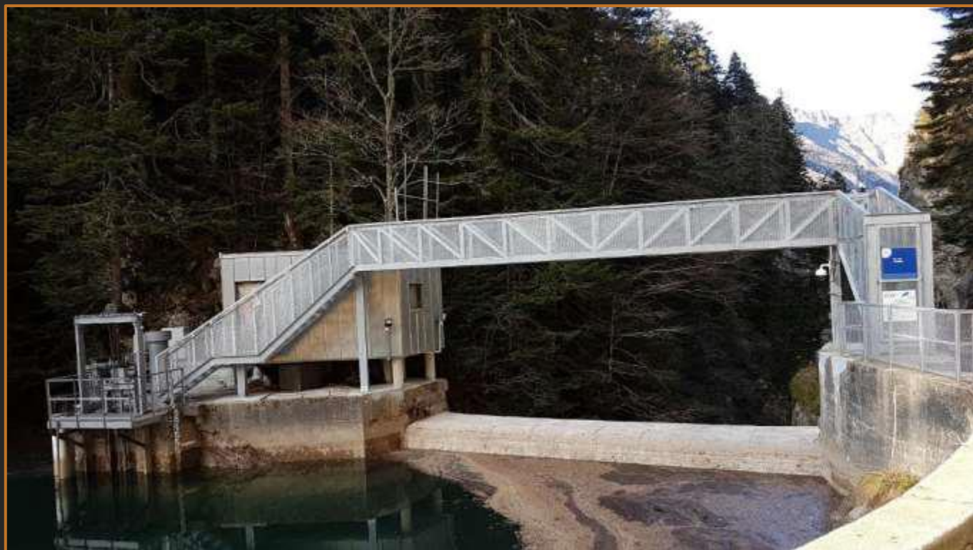
Passerelle sur barrage EDF (12 mètres)
