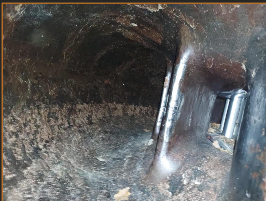
Rechargement de pré-directrices base fonte
