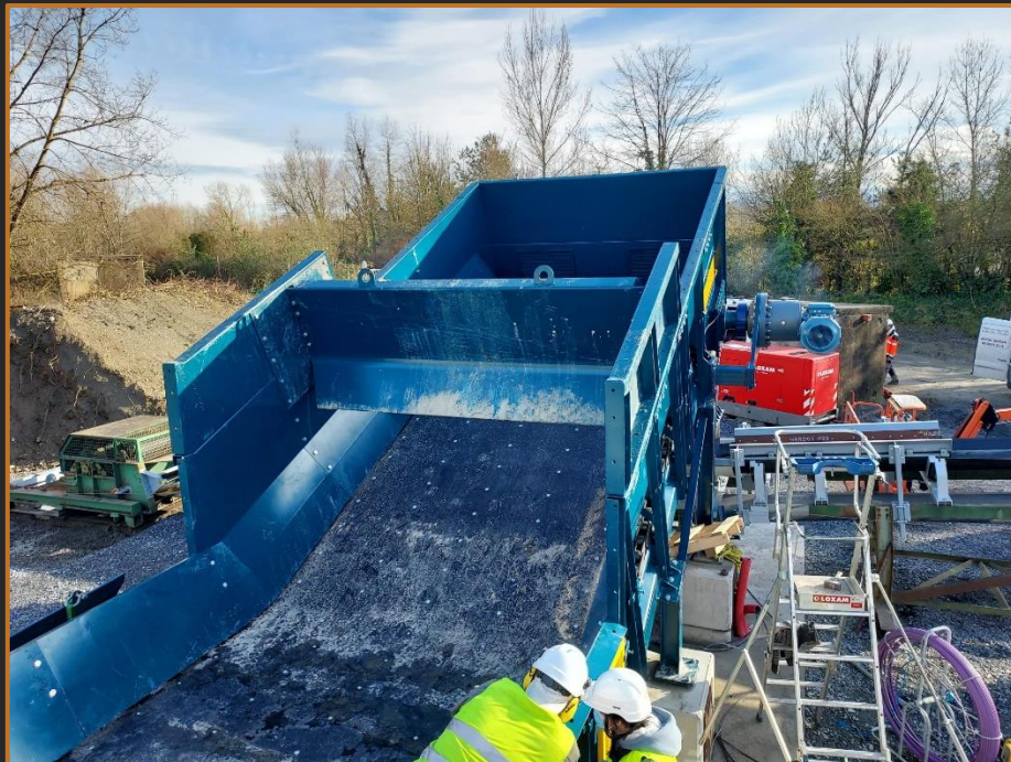
Montage sur site d'un déchargeur à granulats
