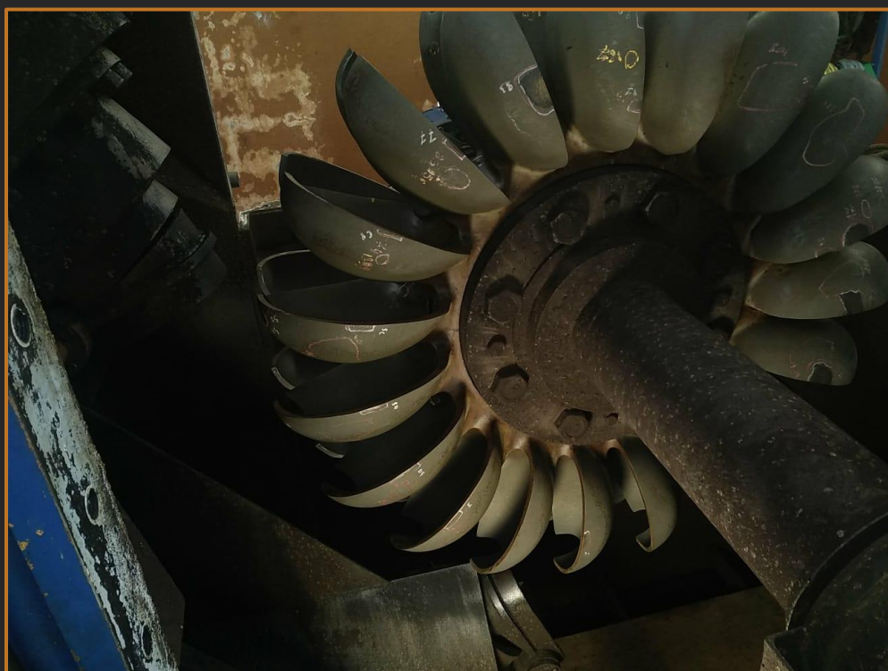
Réparation de defaults sur roue Pelton (Z20C13)
