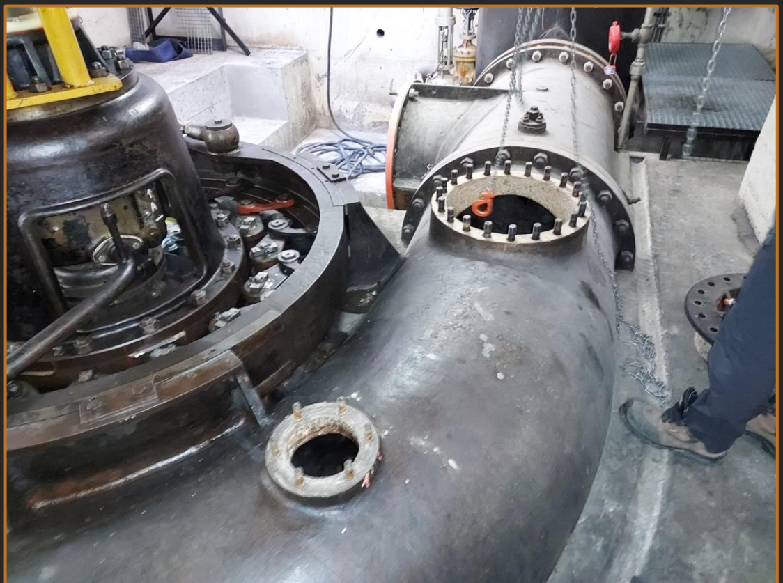
Contrôle géométrique directrices
