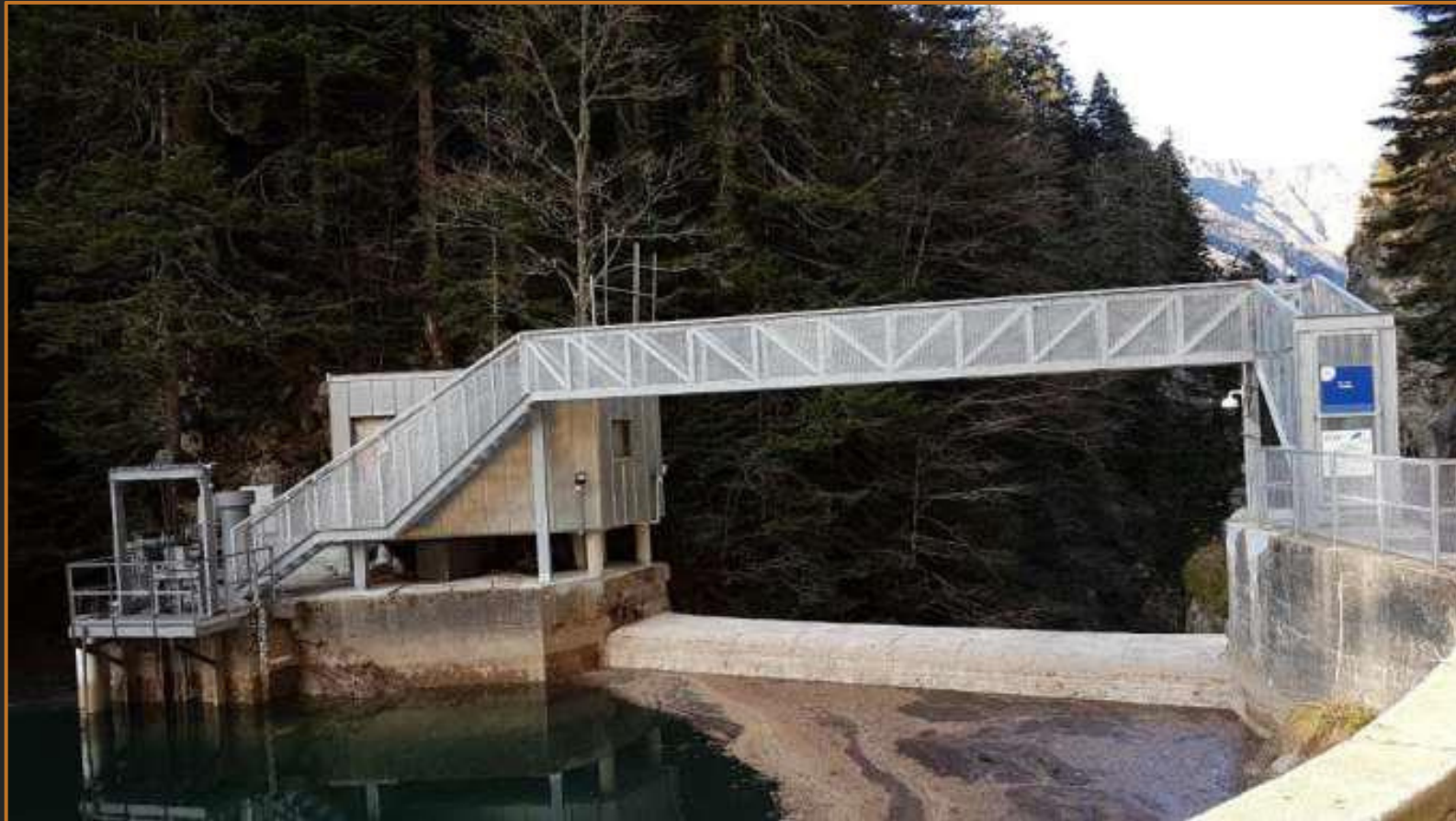
Passerelle sur barrage EDF (12 mètres)
